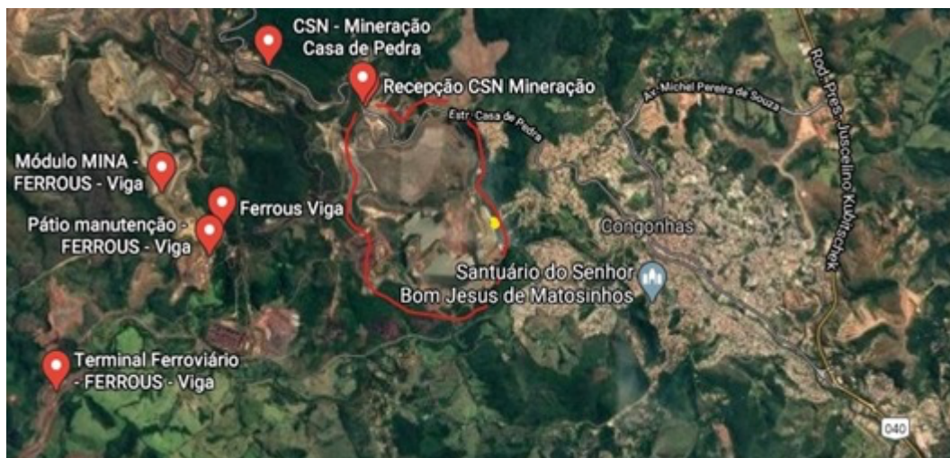
Imagem 7 - Mapa com destaque para o perímetro da barragem Casa de Pedra. A marcação em amarelo é o ponto onde foi observada erosão no perímetro em 2011.
